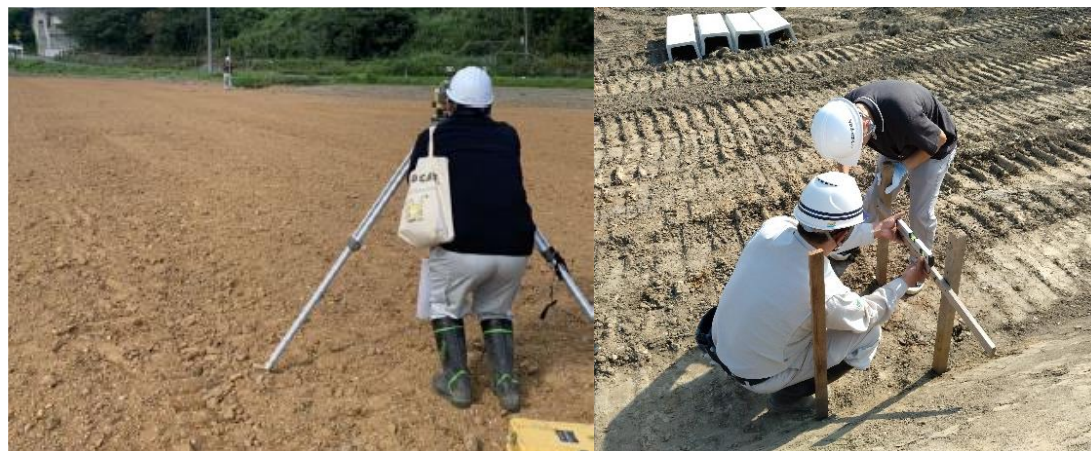
▲農村整備部の業務体験（ほ場整備工事現場での測量実習）の様子
