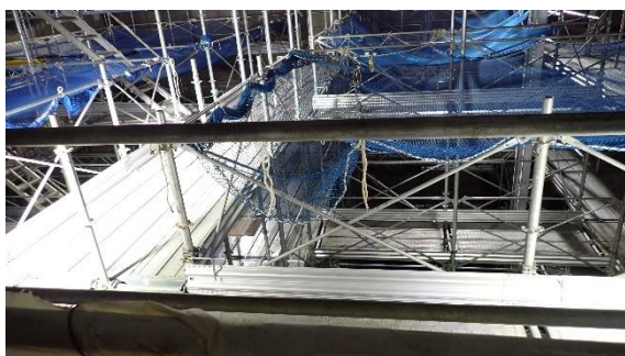
(写真 4－1) 廃棄物貯留ピット内の足場の設置状況
