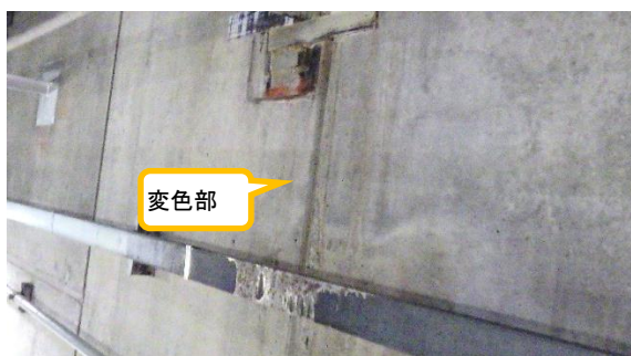
(写真 5－2) 廃棄物貯留ピットの外壁 (コンクリートの継ぎ目部分)
