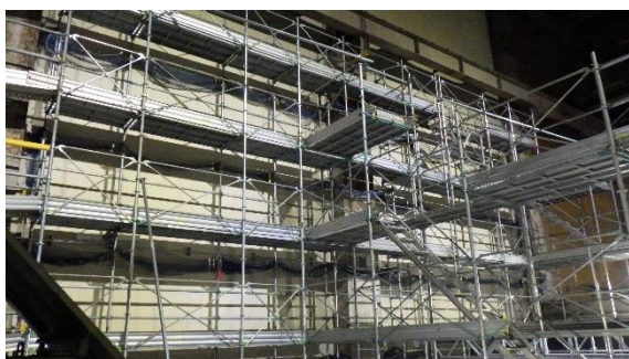
(写真 4－2) 更新された廃棄物貯留ピット上部の耐火ボード
