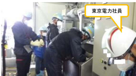
(写真 3) 東京電力社員による作業確認の状況
