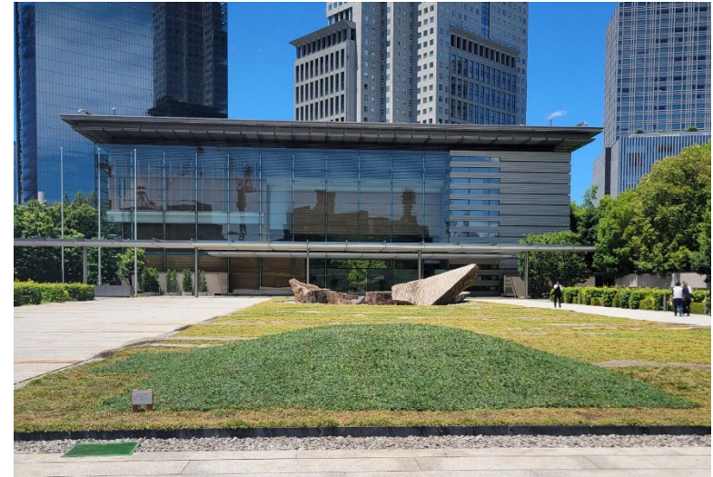
施工後の様子
