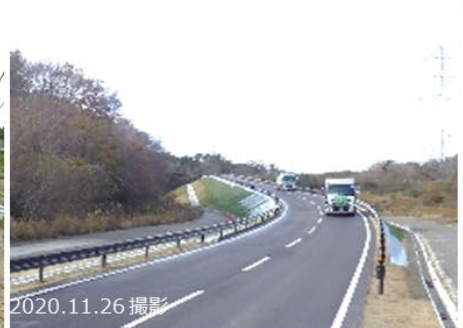
④工事用道路の整備（完了）
