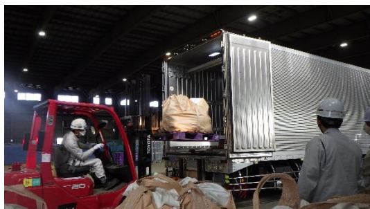
除去土壌の積込作業
