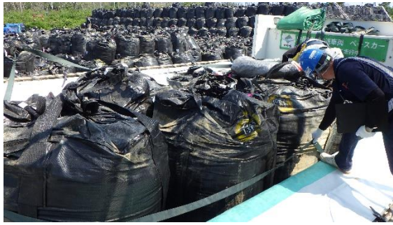
飛散・流出防止対策（固縛）
