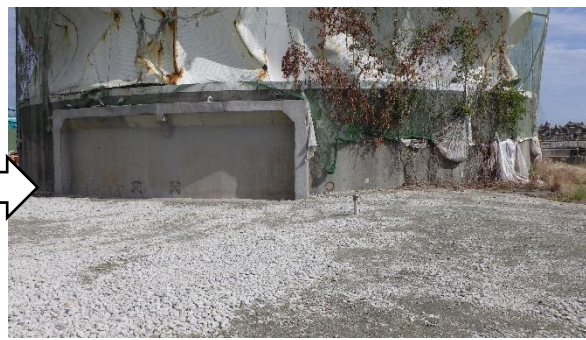
(写真1-2) SPTポンプ室撤去後の状況 ※令和7年10月8日撮影
