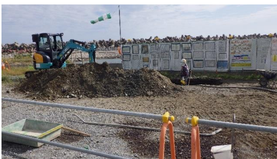
(写真3) 掘削作業の状況
