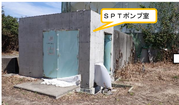
(写真1-1) SPTポンプ室の外観 ※令和7年8月5日撮影
