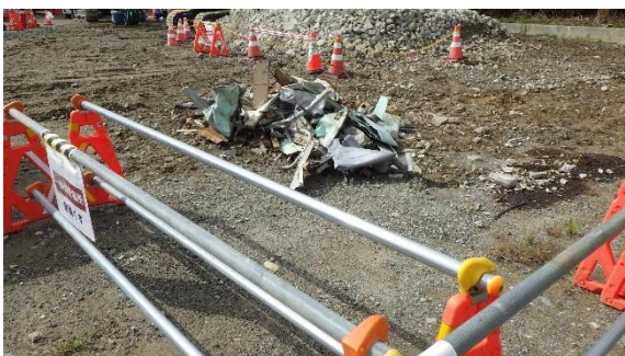
(写真2-2) 瓦礫等の仮置き状況
