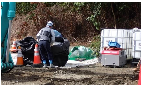
(写真2-1) 瓦礫等の分別作業の状況
