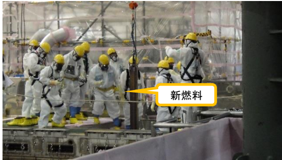
(写真5) 新燃料取出し作業の状況
