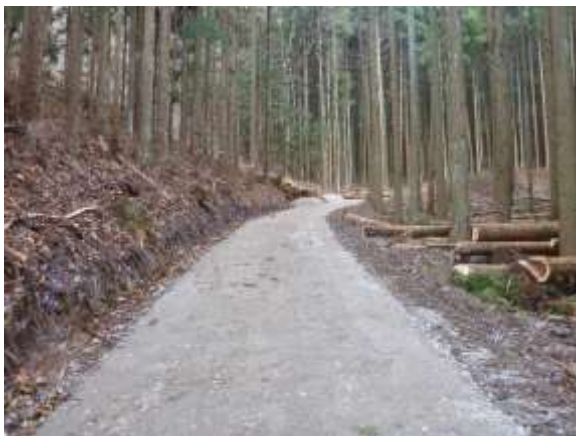
森林作業道の開設
