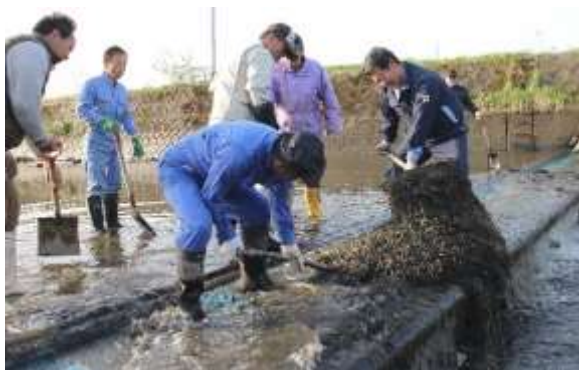
地域ぐるみでの堰の土砂上げ作業
