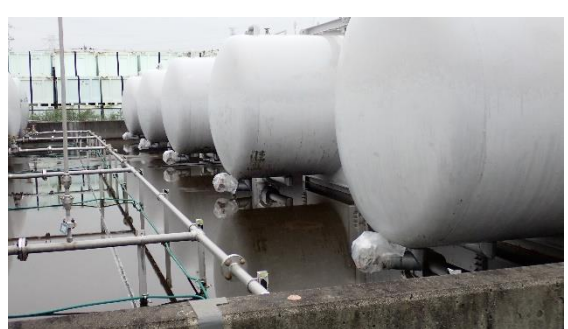
(写真 5 ②) 防油堤内の状況
