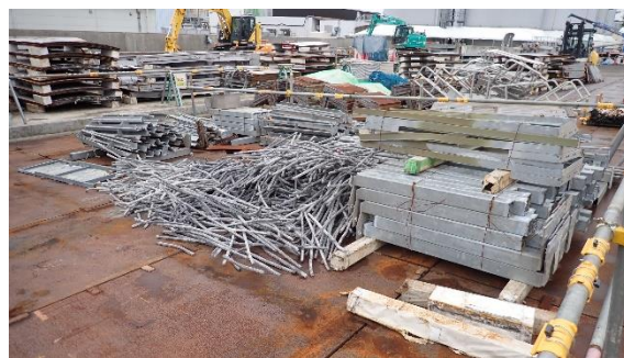
(写真 2 ②) 鉄筋等の解体片
