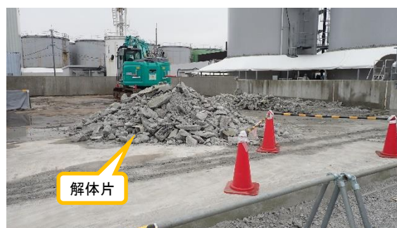
（写真1②）堰の解体片
