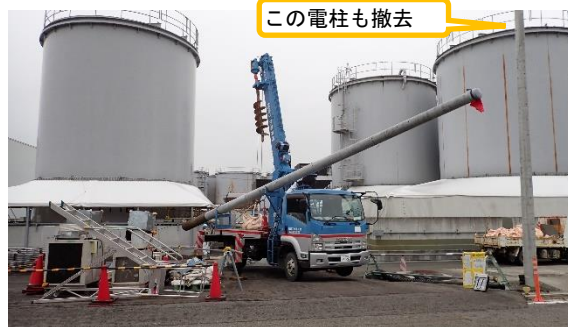
(写真 4) 電柱の撤去
