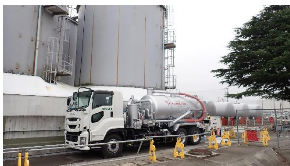
(写真 3) J 8 タンク内清掃等の状況
