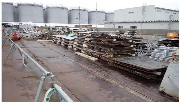
(写真 2 ①) 溶接タンクの解体片
