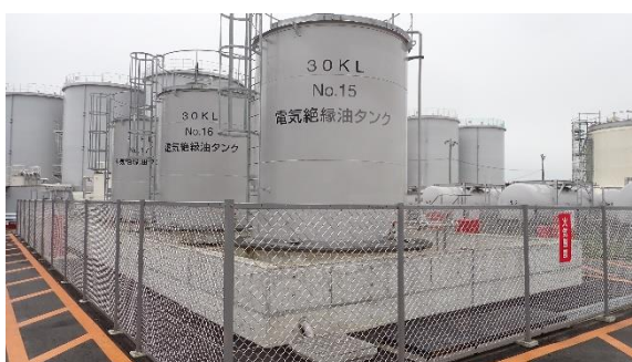
(写真 6) 新設タンクの設置状況
