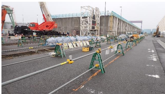
(写真 1-1) 北側エリア増設に向けた準備工事（資材搬入等）の状況①
