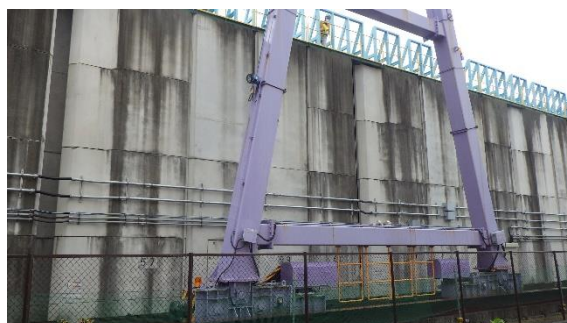
(写真 1-6) 大型クレーンによる H I C の吊上げ作業②
