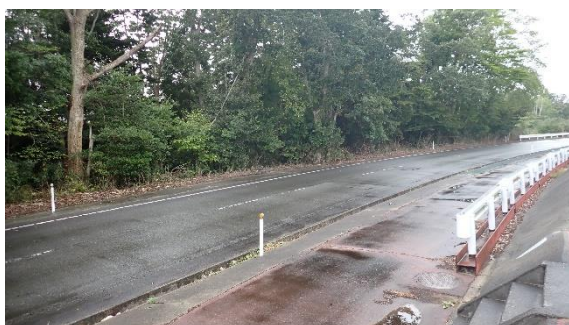
(写真 5-1) MP No. 7 の周辺状況①
