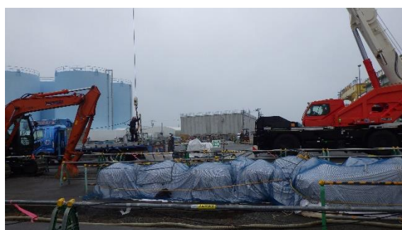
(写真 1-4) 北側エリア増設に向けた準備工事（資材搬入等）の状況④
