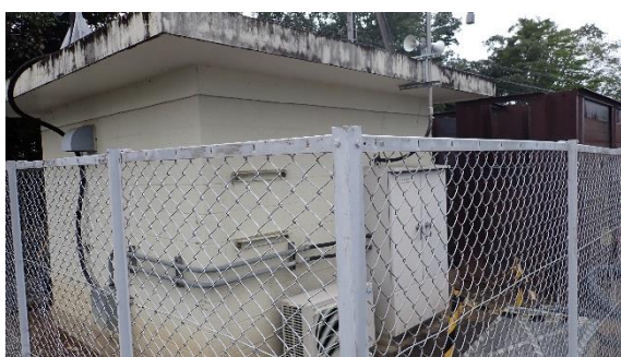
(写真 4-1) MP No. 7 の設置状況①
