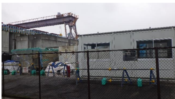
(写真 1-5) 大型クレーンによる H I C の吊上げ作業①
