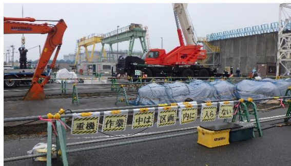
(写真 1-2) 北側エリア増設に向けた準備工事（資材搬入等）の状況②
