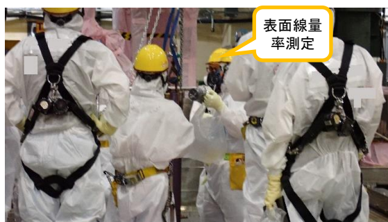
(写真 4 ③) 表面線量率の測定
