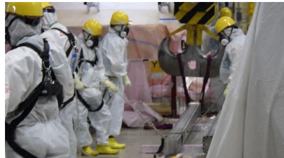
(写真1②) 収納缶の装填作業
