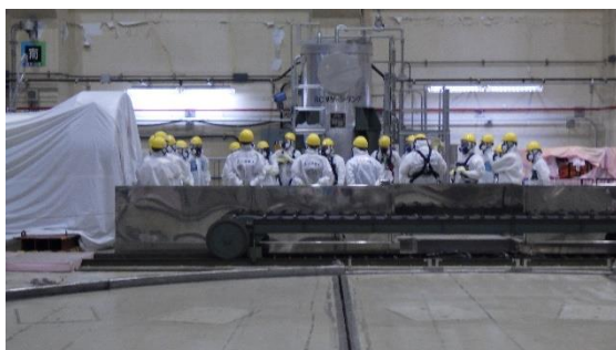
(写真2) 作業引継ぎの状況
