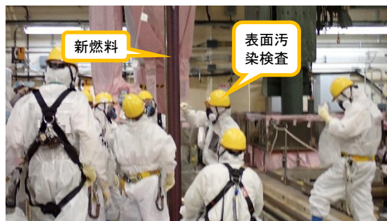
(写真 4 ②) 新燃料の表面汚染検査
