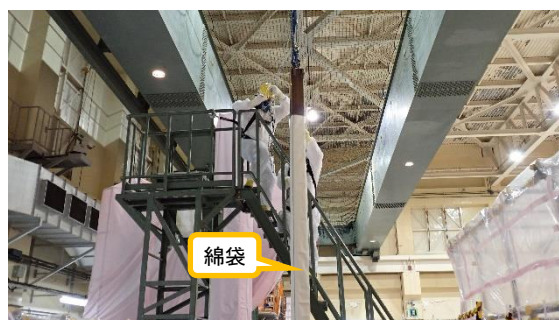
(写真 5) 綿袋による新燃料の養生
