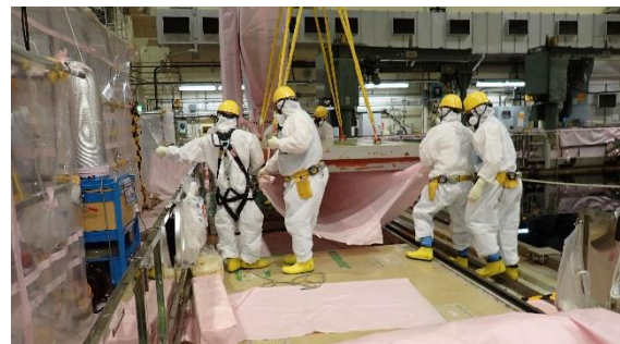
(写真3) 新燃料貯蔵庫の蓋の取外し
