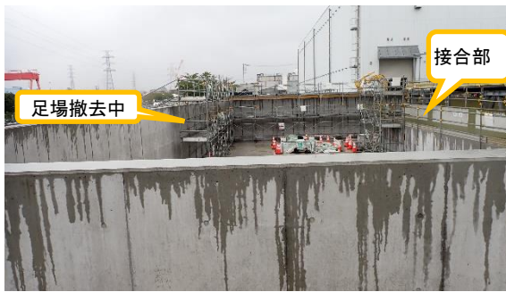
(写真1③) 外堰拡張工事の状況(南側)
