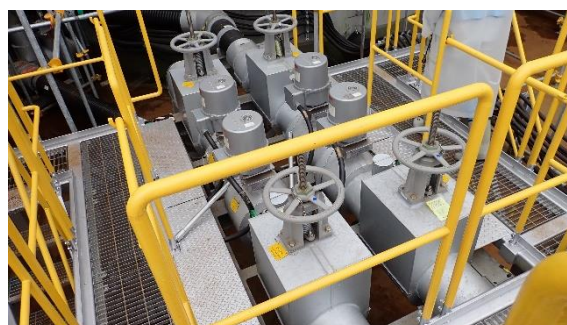
(写真 8 ④) 弁操作及び開閉確認時の歩廊整備状況
