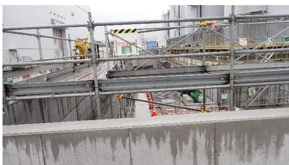
（写真 1①）外堰拡張工事の状況（西側）
