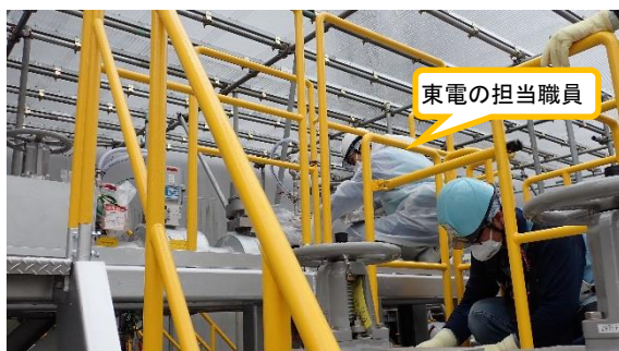
(写真 6) 貯留水移送の系統構成作業
