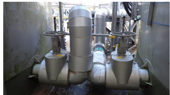
(写真4③) 入口弁の状況
