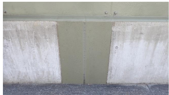
(写真1④) 外堰接合部の防水対策
