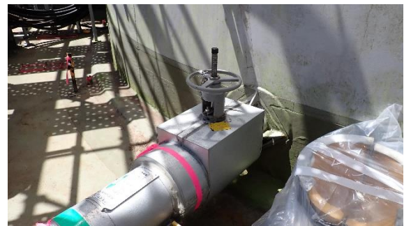
(写真4①) 出口弁の状況
