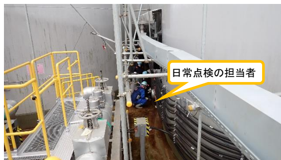
(写真 5) タンクの日常点検状況
