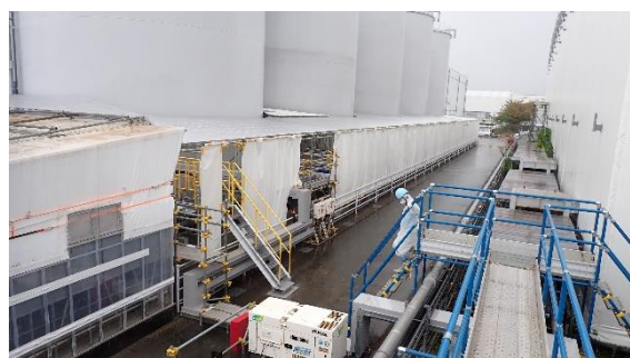
(写真 8 ②) エリア北部における屋根カバー及び雨除けカバーの状況
