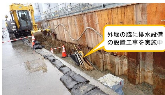
（写真 1②）外堰拡張工事の状況（西側）
