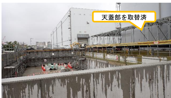
(写真3) 外堰嵩上げの状況(南西側)
