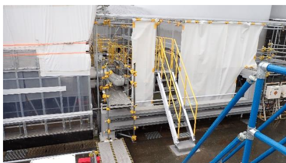
(写真 8 ③) 点検用歩廊の完成状況
