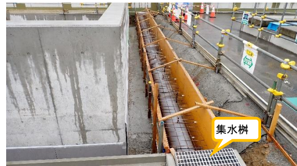
(写真2②) 外堰脇の排水設備工(南東) (排水管及び集水樹の設置)
