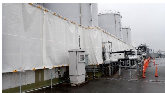
(写真 8 ①) エリア東側における雨除けカバーの設置状況
