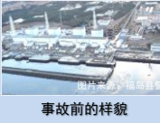
事故前的样貌
