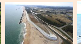
磐城市：海岸堤防
