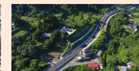
国道349号（福岛复兴再生道路）（川俣町大綱木工区）
