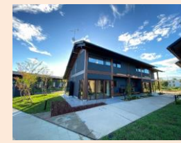
双叶町：站西住宅
