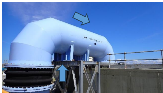
(写真 4 ②) 放水立坑の状況
