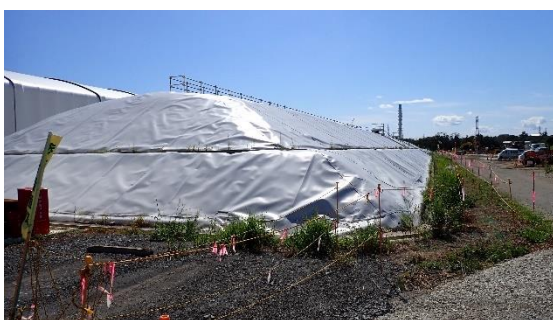
(写真 4) 第 2 槽の状況
