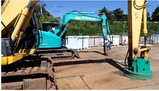
(写真5) 重機の配備状況
