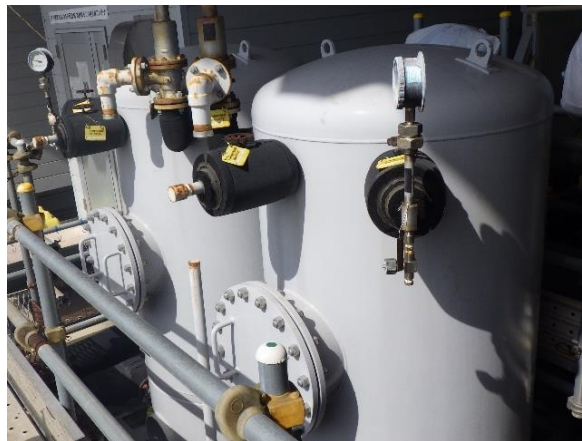
(写真5) 冷却水循環ポンプ並びに入口配管及び入口弁の設置状況 (写真6) サージタンク
