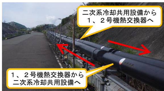
(写真7) 二次系冷却配管の敷設状況
