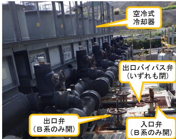
(写真3) 空冷式冷却器への冷却水入口及び出口弁の開閉状況 (写真4) 空冷式冷却器の操作盤
