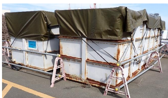
（写真9）伐採木一時保管エリアⅤ付近の防火水槽の設置状況
