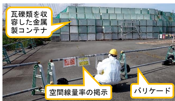
(写真13) 瓦礫類一時保管エリアVのコンテナ及びバリケードの設置状況
