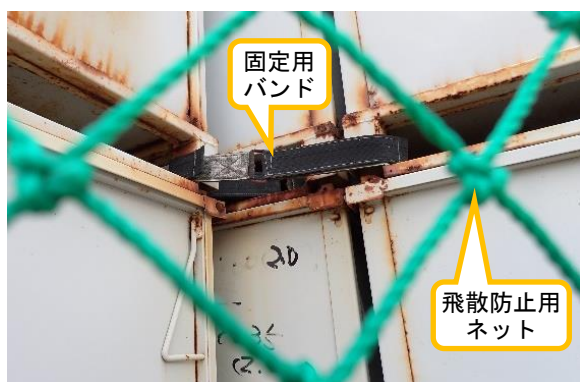
(写真14) コンテナのバンドによる固定状況及びネットによる飛散防止状況
