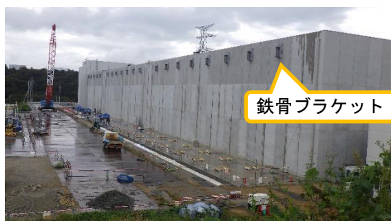
(写真 4 ①) 保管庫全景
