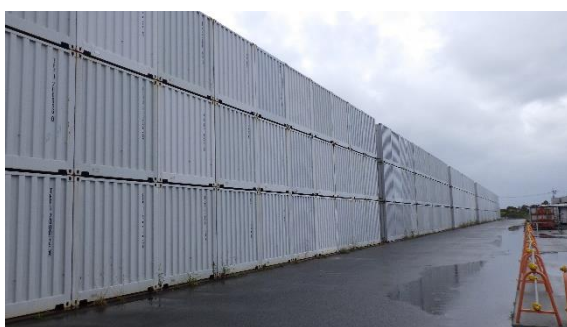
（写真1①） エリアA A既設部の状況
