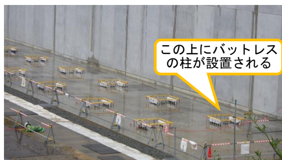
(写真 4 ②) 基礎スラブの状況
