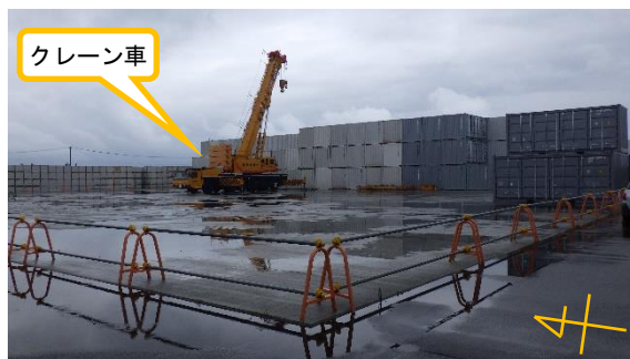
(写真 2 ①) エリア A A 拡張部の状況
