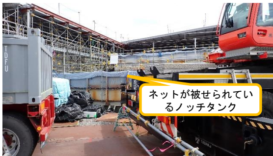
(写真 2) 入れ替え作業中のノッチタンク
