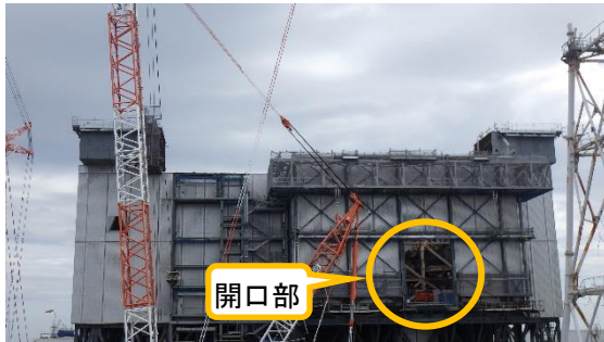
(写真 4－2) 大型カバー全景② (令和 7 年 9 月 2 5 日撮影) ※西側の開口部を除き上部架構の 設置が完了
