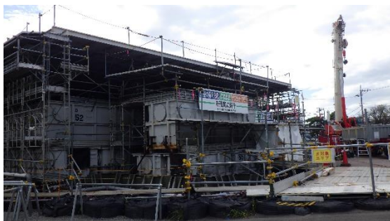
（写真1－1） エリアN外観① ※北西側から撮影
