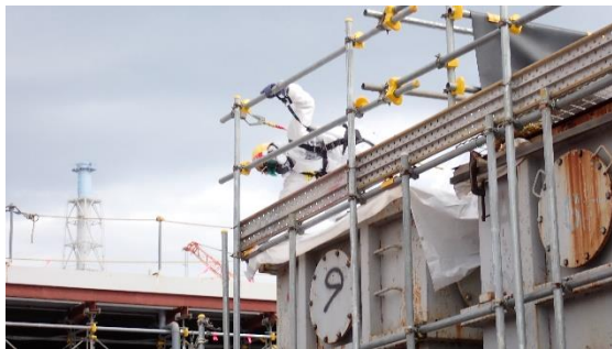
(写真 3) 汚染土壌運び出し作業の状況
