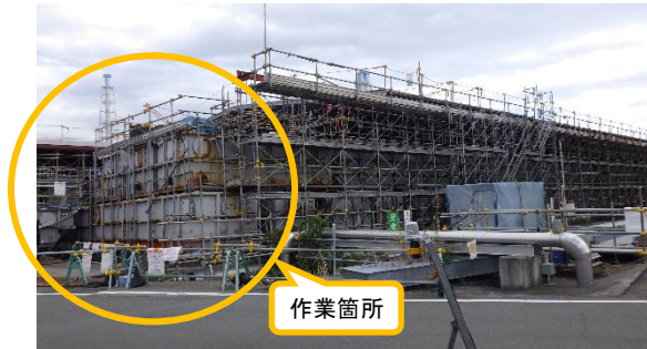
(写真 1－2) エリアN外観② ※南西側から撮影
