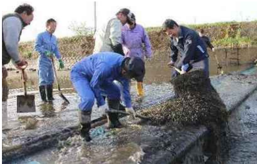
地域ぐるみでの堰の土砂上げ作業
