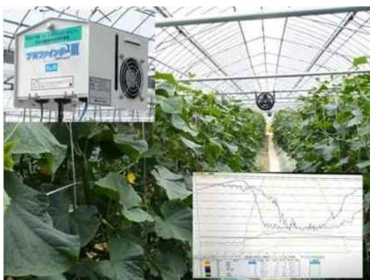
園芸施設の環境測定装置
