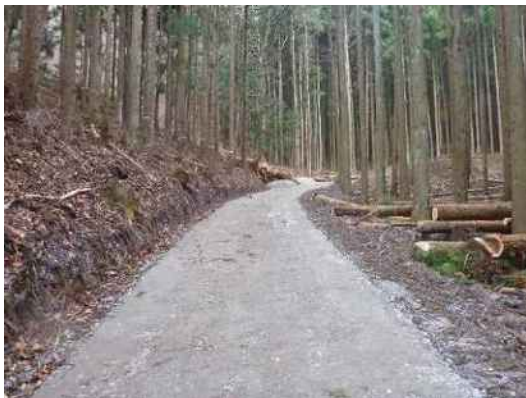
森林作業道の開設
