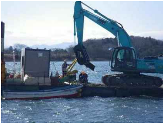
起重機船による漁場内に残存しがれき等の除去作業
