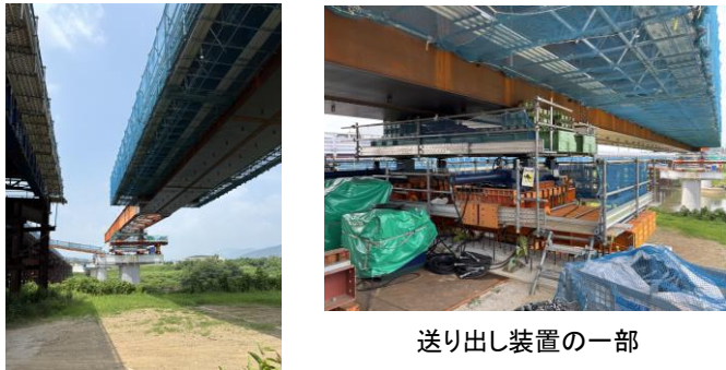
送り出し作業時の桁下の様子
