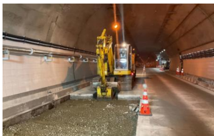
《 路面隆起対策工事 》
