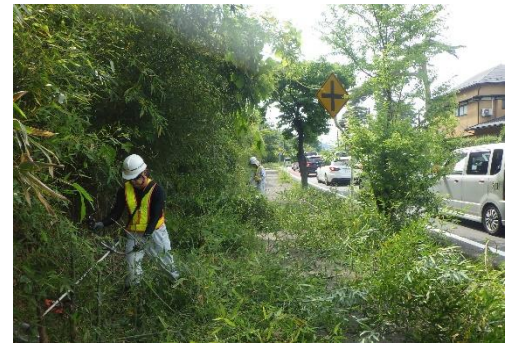
【補修作業（歩道除草の様子）】
