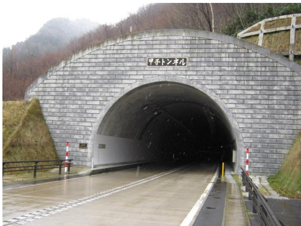
【甲子トンネル下郷側坑口】
