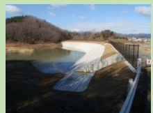
老朽化したため池の改修
