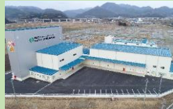
営農再開に向けた 施設整備
