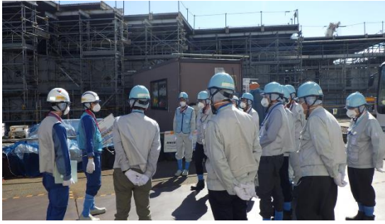
(写真 8) 瓦礫類一時保管エリア N における廃 棄物の保管状況の確認
