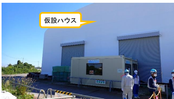
(写真6) 仮設ハウスの状況 ※内部で瓦礫類の取り出し作業が行わ れている。
