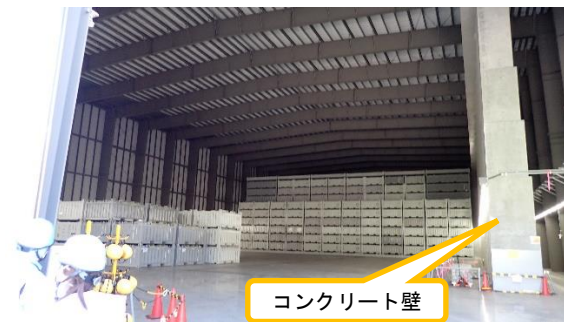
(写真5) 固体廃棄物貯蔵庫第10—B棟の保管 状況
