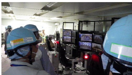
(写真7) 遠隔による重機の操作状況 ※作業員はモニターを見ながら重機を 操作している。
