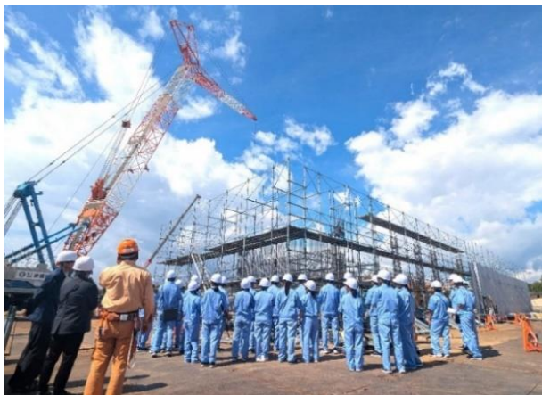
《建築工事現場見学》
