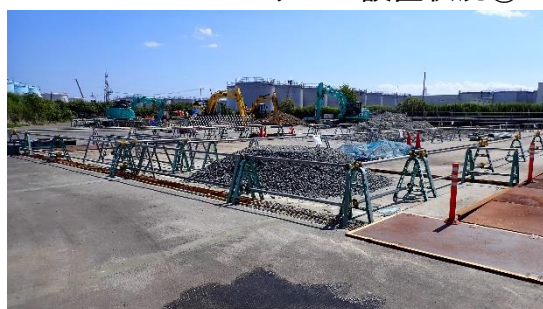
(写真4-1) Eエリア内でのJ9 タンク解体に伴う措置状況①
