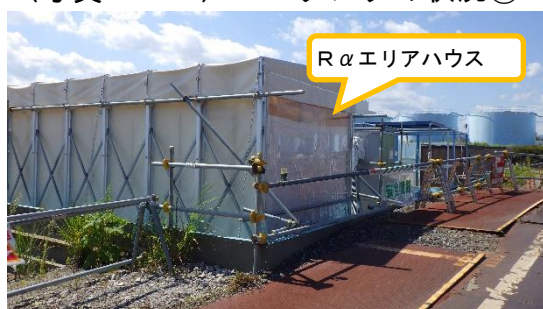
(写真2) スラッジ処理のための Rαハウスの設置状況①
