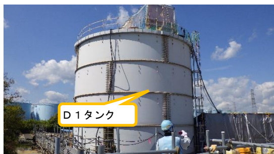
(写真1-1) D1タンクの状況①
