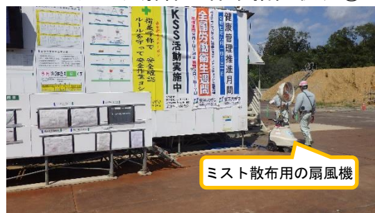
(写真5-2) 現場事務所出入口に 設置されたミスト扇風機
