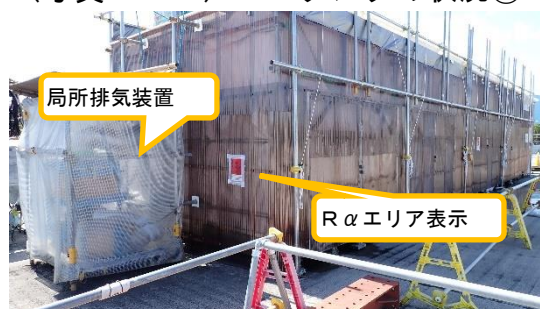
(写真3) スラッジ処理のための Rαハウスの設置状況②
