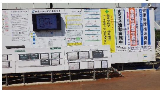
(写真5-1) JAEA第2棟建設 作業現場の安全掲示板
