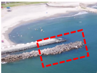
施工前（R7年7月）
