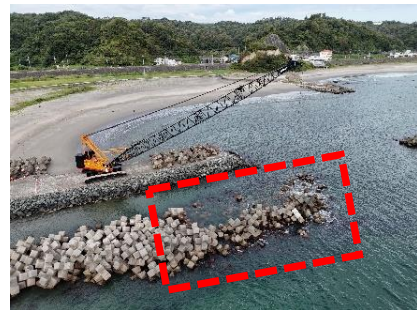
ブロック撤去中（R7年9月）
