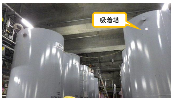
(写真 3) 吸着塔の設置状況
