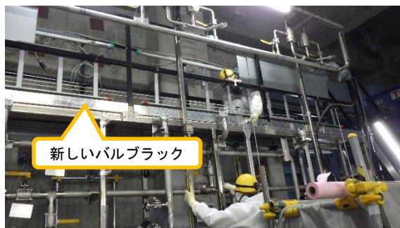
(写真 1) バルブブラックの設置作業の状況
