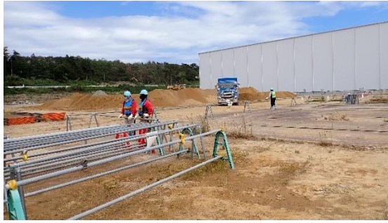
(写真 6) 監視員の配置状況
