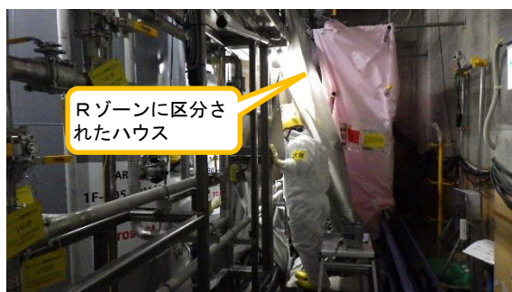
(写真 2) ハウスの設置状況
