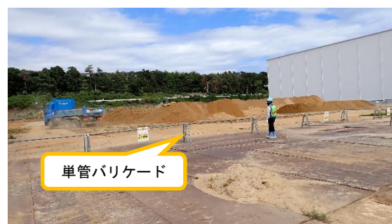
(写真 5) 重機作業エリアの区画状況
