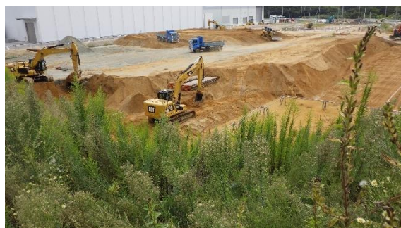
(写真 4) 掘削作業の状況
