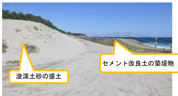
(写真 2) 海側の堤防の状況
