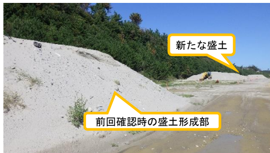
(写真 1－2) 北側護岸エリア浚渫土砂置き場の 状況②（中央部：北側を撮影）
