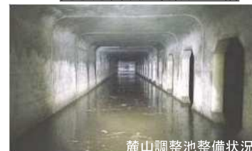
雨水貯留浸透施設の整備
