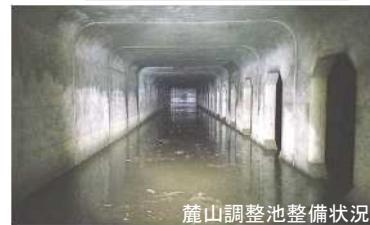
雨水貯留浸透施設の整備
