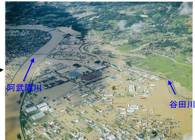
昭和61年8月洪水 阿武隈川合流点付近
