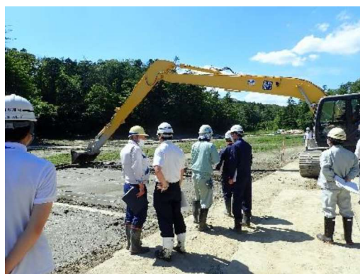
直接掘削による除去工 (県営モデル事業の研修会の様子)
