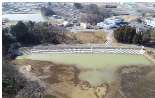
防災工事施工後 （同地区）
