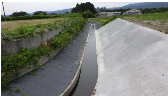
防草シート工及びモルタル吹付工
