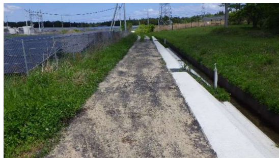
施工後 （水路のり面）シールコンクリート工 （管理道路）プライムコート工
