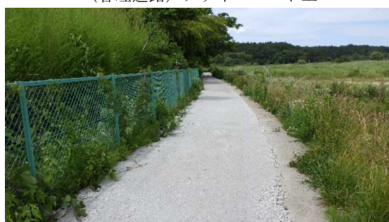
セメント系固化材による道路改良
