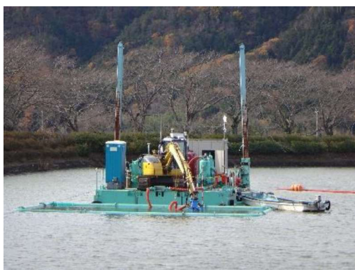
浚渫による除去工
