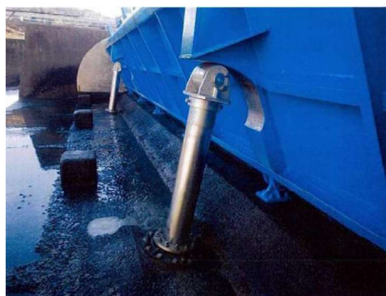
ゲート整備補修 (扉体塗装、水密ゴム鋼管、油圧シリンダー交換) (施工後) 愛宕堰頭首工(伊達市)
