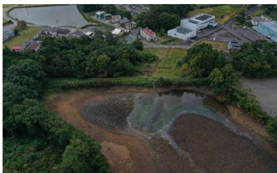
防災工事施工前 荒池地区（大玉村）
