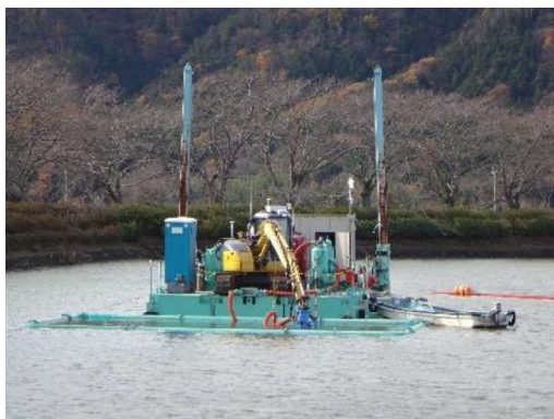
浚渫による除去工
