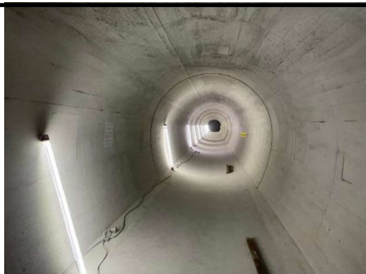
水路トンネル覆工状況
