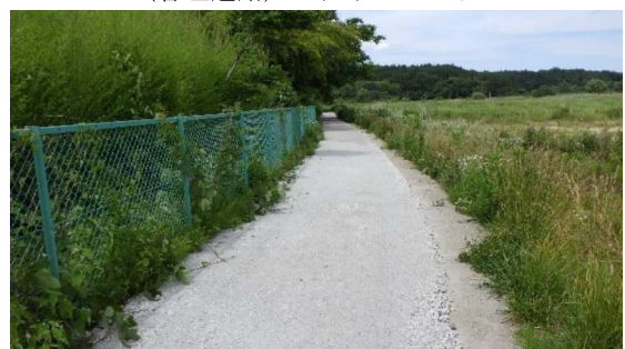
セメント系固化材による道路改良
