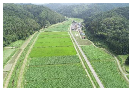
堰場地区におけるほ場整備後の状況 （会津若松市）
