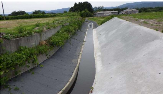
防草シート工及びモルタル吹付工
