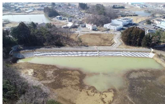
防災工事施工後 （同地区）
