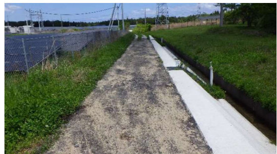
施工後 （水路のり面）シールコンクリート工 （管理道路）プライムコート工
