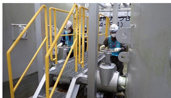
(写真1②) 連結弁の全開作業
