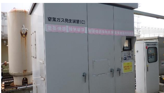
(写真 2) 既存の窒素ガス分離装置 (C) の構 成の一例 (写真は窒素ガス発生装置)
