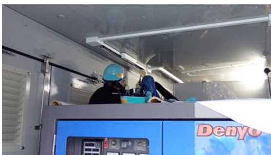
(写真 1－6) 接続工事の状況
