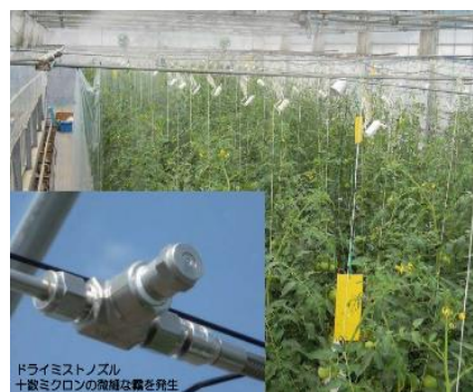
ミスト冷房による高温対策
