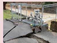
水道の復旧 (被災した浄水場)
