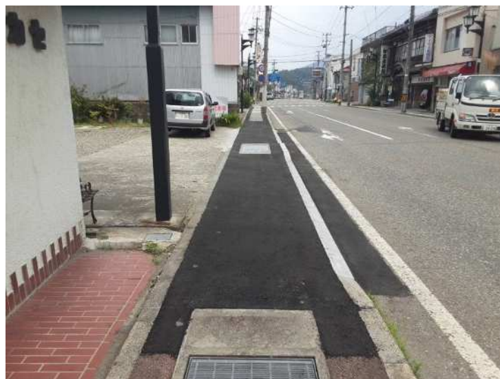
R7工事完了後
