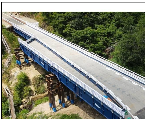
8月4日 区画線やガードレールを設置
