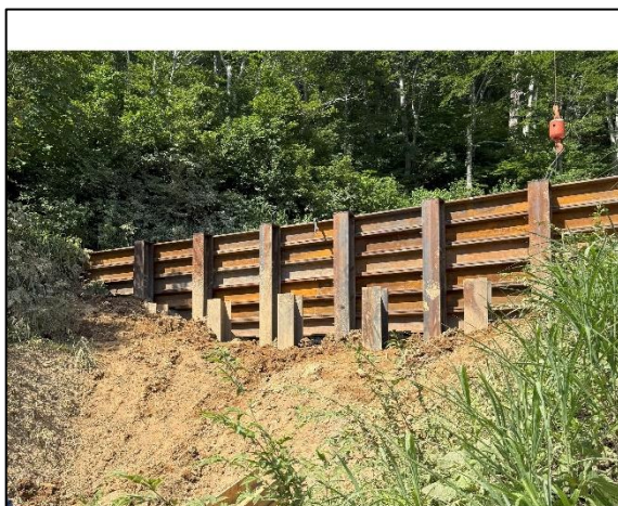
6月30日 橋台の土留め壁が完成
