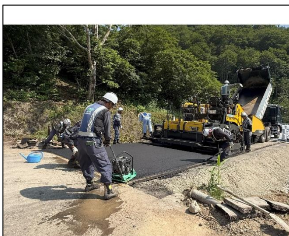
施工時のアスファルトは 150℃を超える
