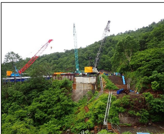
大型クレーンが集結
