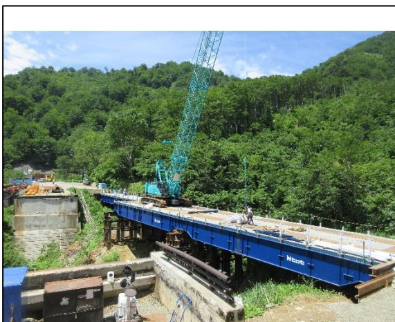
7月16日 橋桁が新潟側の橋台に架かる
