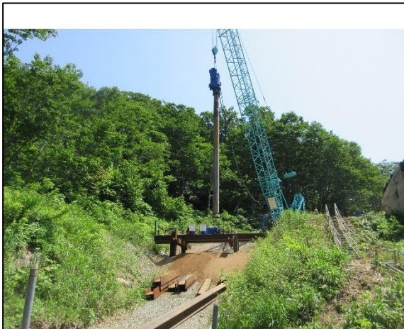
6月19日 杭打ち工事を開始
