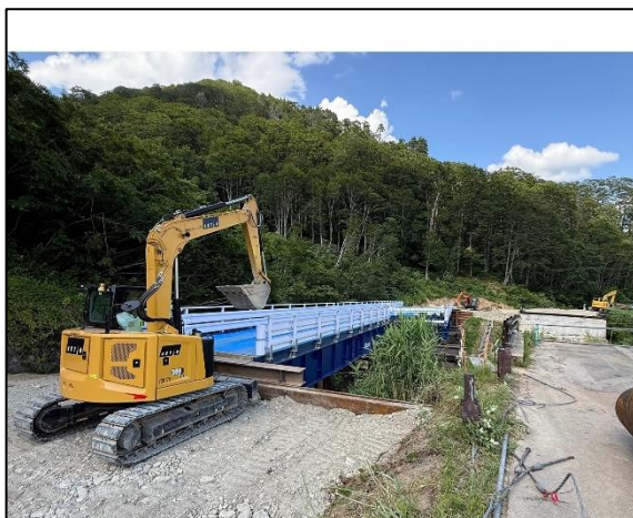
仮橋の前後の道路を整備していく
