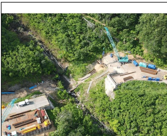
ドローンから見た作業風景
