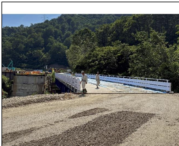
7月28日 仮橋前後の道路盛土が完了
