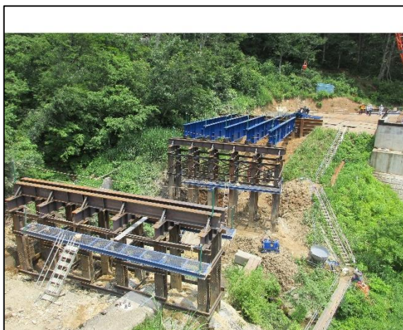
7月10日 橋桁の架設が始まる
