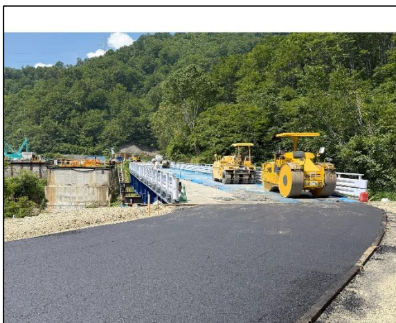
7月29日 舗装工事がスタート
