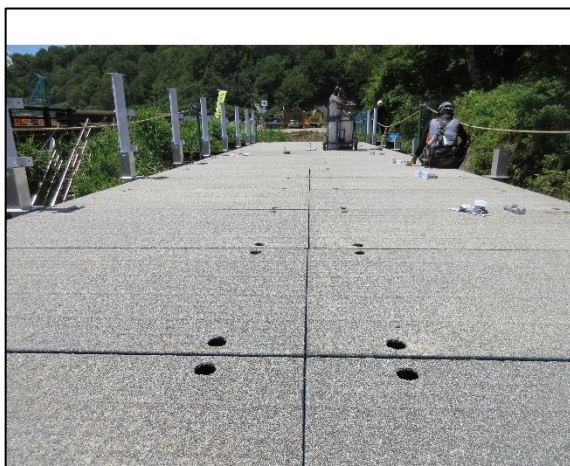
仮橋の表面はノンスリップ加工
