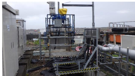
（写真1②）物揚場排水路閉止ゲート
