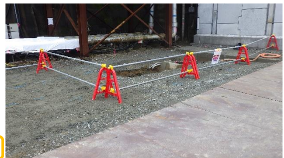
(写真 6) 保護カバー設置工事の状況
