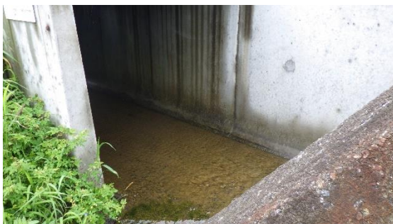
（写真1①）物揚場排水路放流口
