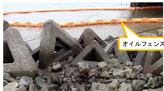
(写真 4) 排水先の港湾内の状況
