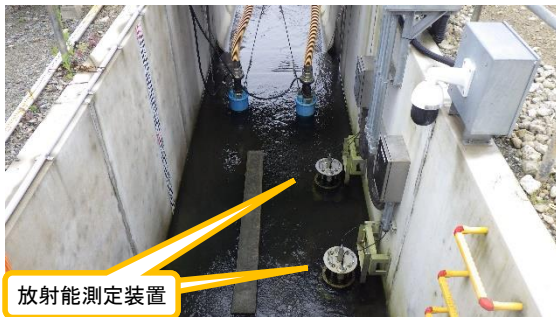
(写真 2 ②) D 排水路の状況
