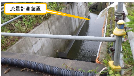
(写真 3) A 排水路流量計
