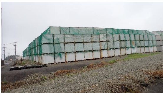
(写真 1－2) 1 m³コンテナの保管状況 ※南東側から撮影
