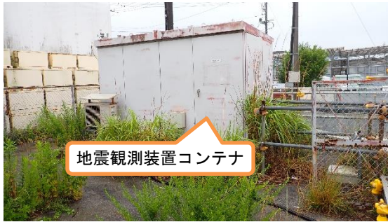
(写真 4－2) 自由地盤系地震観測地点の状況②
