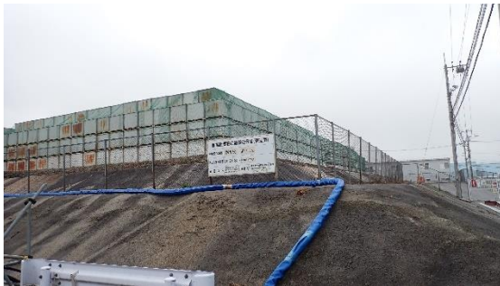
(写真 1－1) エリア J の外観 ※北東側から撮影
