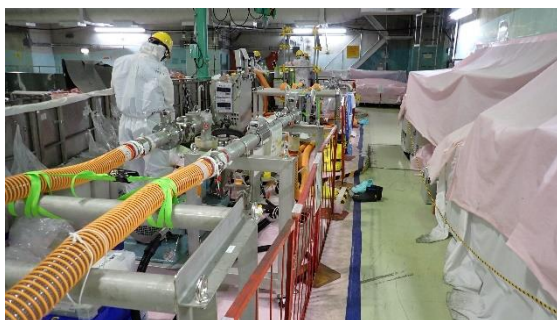
（写真2－1） フィルター交換作業①
