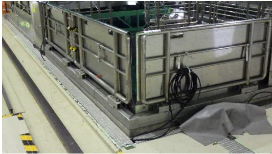
(写真 3 - 1) 共用プール周囲の状況①
