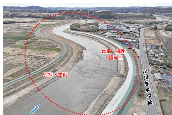
夏井川12工区（小川町下小川地内） 令和7年3月完了
