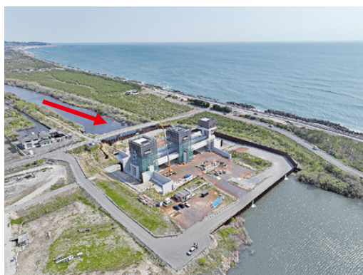
夏井川 水門工
