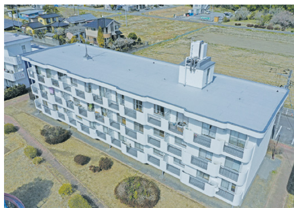
鯨岡団地 8号棟 外壁改修工事 (改修後)
