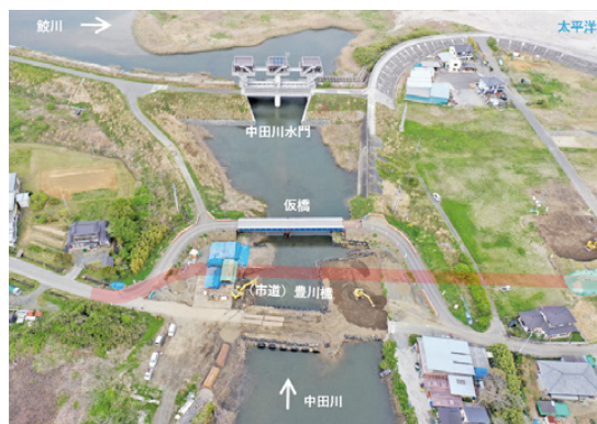
中田川 橋梁工
