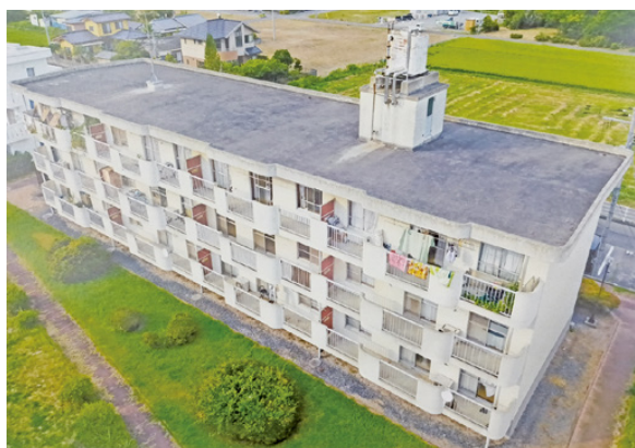
鯨岡団地 8号棟 外壁改修工事 (改修前)
