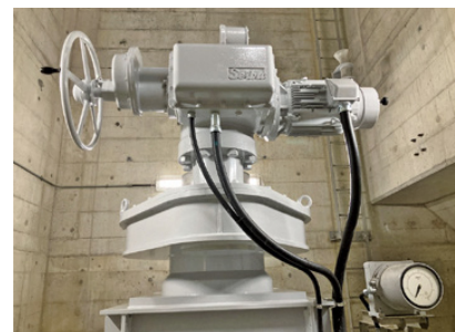
【四時ダム】洪水吐きNo1更新竣工
