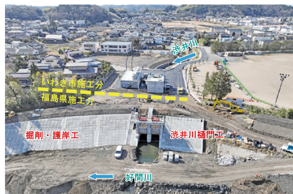
好間川1工区（平北目町地内） 令和7年3月完了
