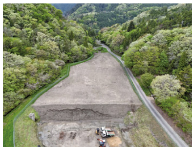
【高柴ダム】堆砂除去作業状況
