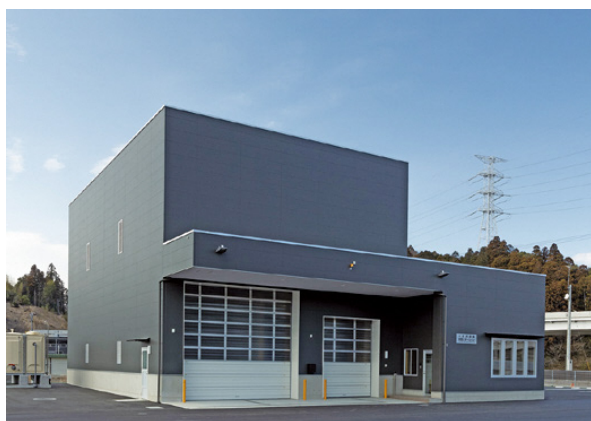
小名浜道路 除雪ステーション
