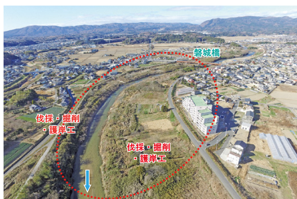
夏井川5工区（平下平窪地内）施工前
