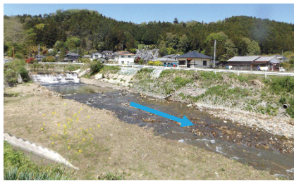
新川（内郷町広畑） 被災状況
