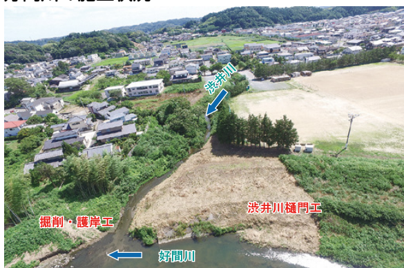
好間川1工区（平北目町地内）施工前
