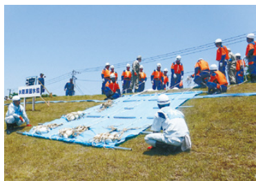
シート張り工法
