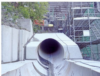
【高柴ダム】発電所導水管撤去状況
