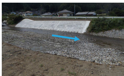
新川（内郷町広畑） 復旧完了
