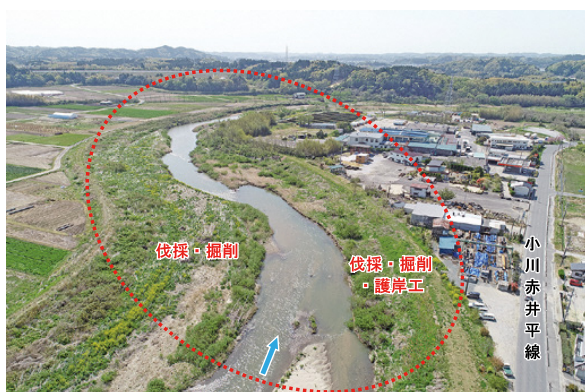
夏井川12工区（小川町下小川地内）施工前
