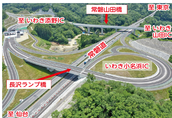
写真提供：東日本高速道路株式会社 小名浜道路（いわき小名浜IC）
