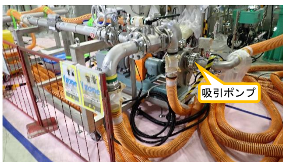
(写真 1－1) 吸引ポンプの設置状況
