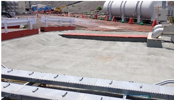
(写真4) 共用プール西側における斜面对策 工事の状況 (未着手：重機メンテナンスヤード)
