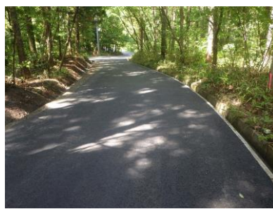
▲林道田代川平線災害復旧状況
