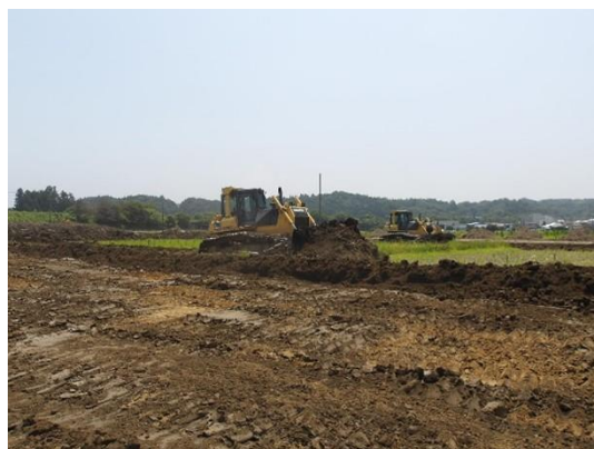
▲ブルドーザーでの表土はぎ
