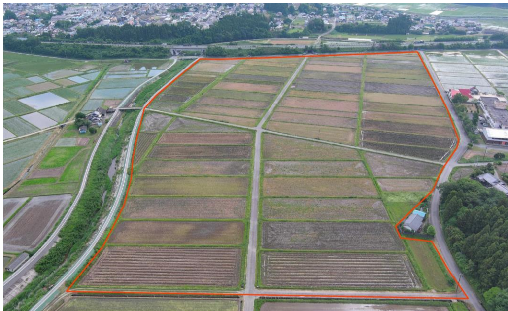
▲本年度の工事範囲全景
