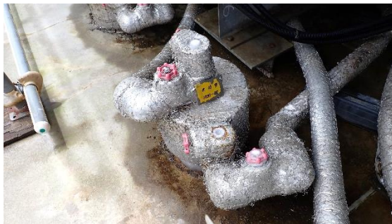
(写真 2) 凍結管上部の状況
