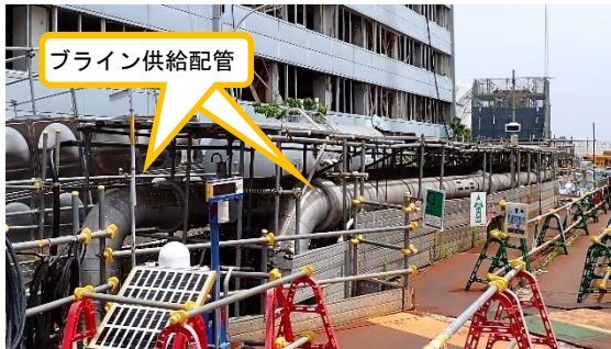
(写真 1－1) ブライン供給移管（3 B L K、1 号 機北西側）の状況
