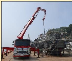
コンクリートポンプ車で型枠の上から、コンクリートを流し入れます
