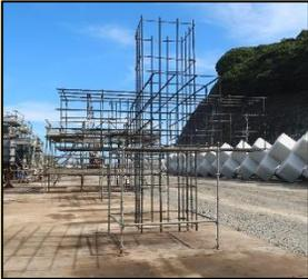
ブロックを強くするため、ブロックの中に入れる鉄筋を組み立てます
