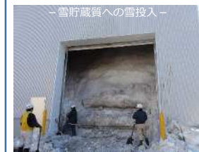
※雪室への雪投入が完了した状態。 最大で573トンの貯雪が可能。
