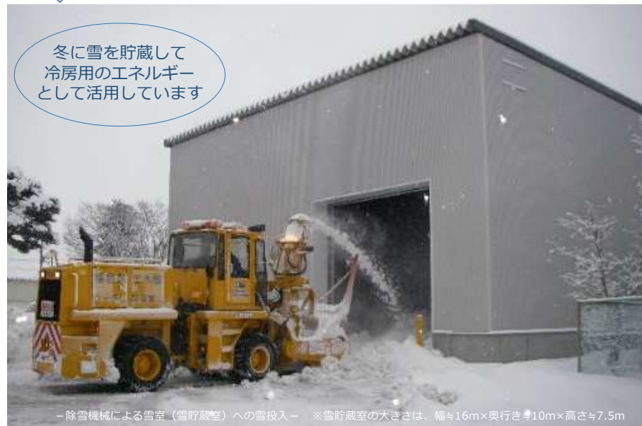
【雪冷房システムのイメージ図】 出典：新エネルギー財団
