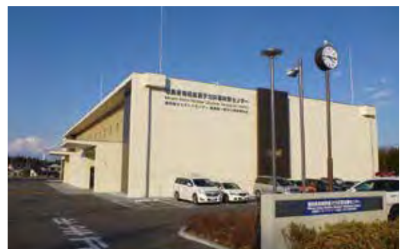
福島県南相馬原子力災害対策センター （南相馬市原町区萱浜字巣掛場45-178）
