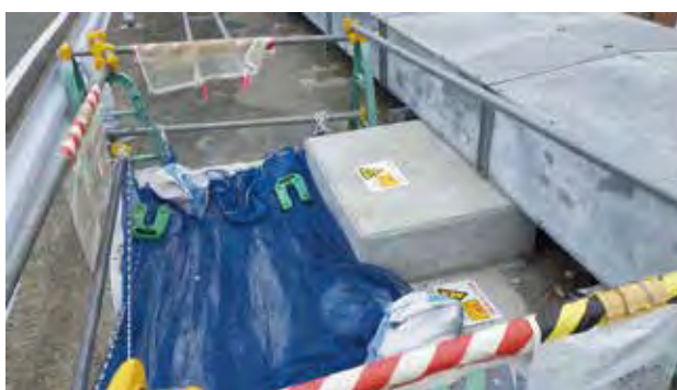
掘削工事現場の状況 (R6.6.28)
