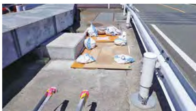
掘削工事現場の状況 (R6.4.25)
