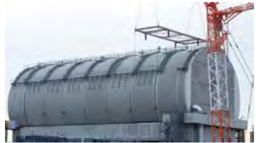
3号機燃料取り出しカバー
