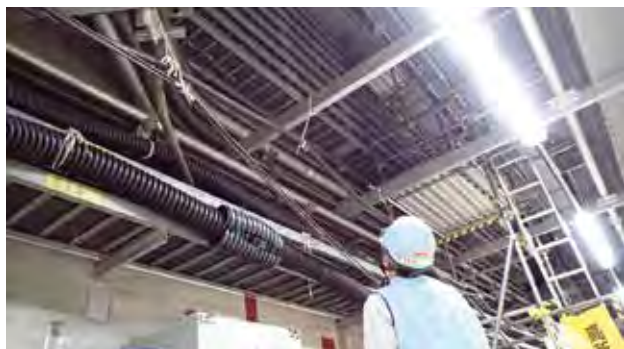
火災報知器作業現場付近を確認している様子
