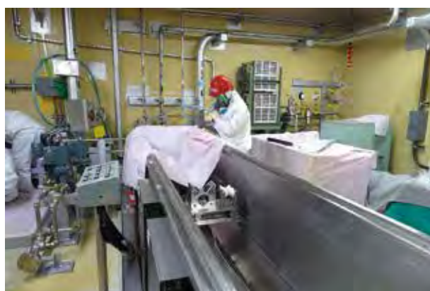
汚染の除去作業状況（東京電力提供）
