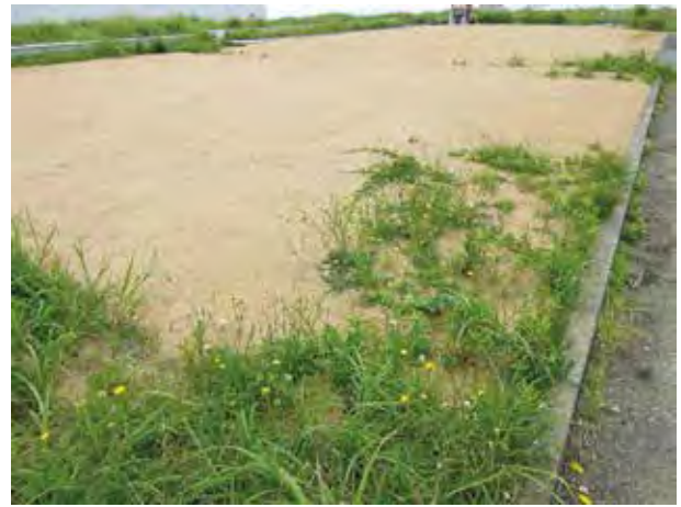
解体後の跡地状況
