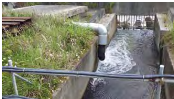
地下水バイパス排水状況
