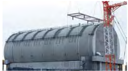
3号機燃料取り出しカバー
